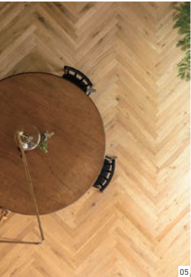
【01】 大開口の窓からウッドデッキを介して内と外が繋がるリビング。 【02】 気積の大きい吹き抜けリビング。 【03】 シンプルな造作キッチン。 【04】 施主がつくったアイロンの造作階段。 【05】 ヘリンボーン張りのフロアはオークの無垢材を使用。
